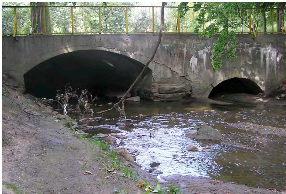
Fot. 133. Wyływ rzeki z kanału zamkniętego pod ulicą Niestachowską (strona lewa). Po prawej widoczne ujście kanału burzowego
