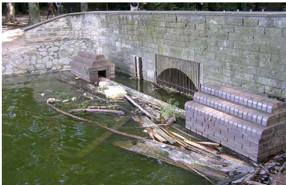
Fot. 132. Jaz piętrzący jeziora Rusałka, skąd woda trafia do zamkniętego kanału
