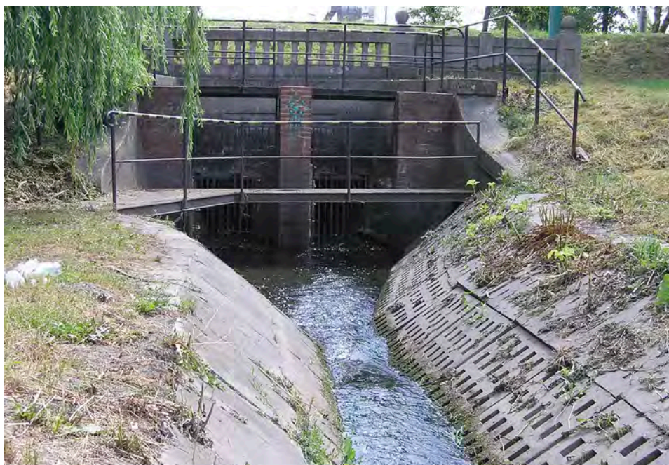
Fot. 137. Ujście rzeki do kolektora Bogdanka przy ulicy Pułaskiego
