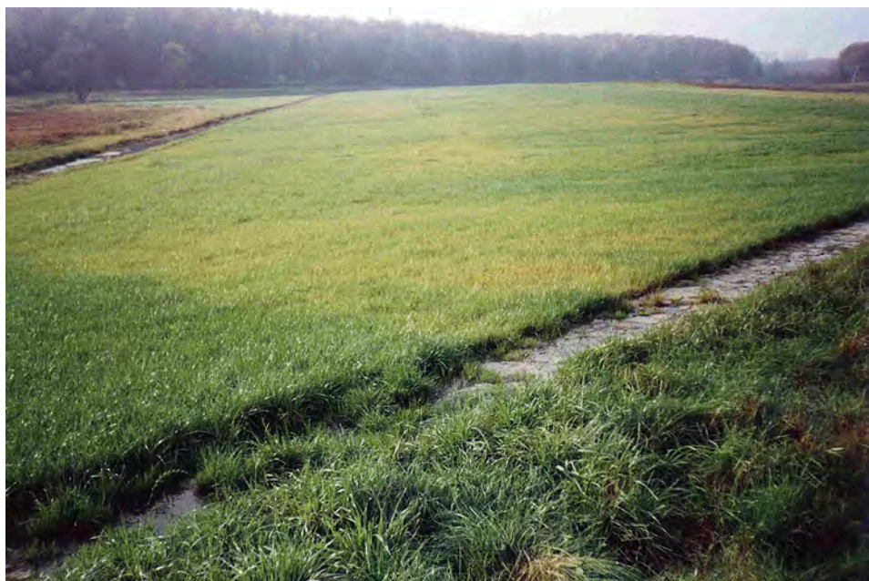
Fot. 82. Oczyszczalnia stokowa w Ogrodzie Zoologicznym (na pierwszym planie kamienny próg rozprowadzający równomiernie wodę u góry stoku)
