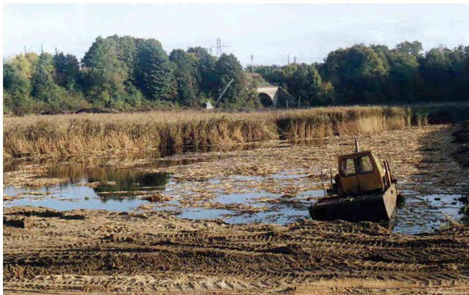
Fot. 60. Usuwanie trzciny i pogłębianie stawu Antoninek w 2003 r.
