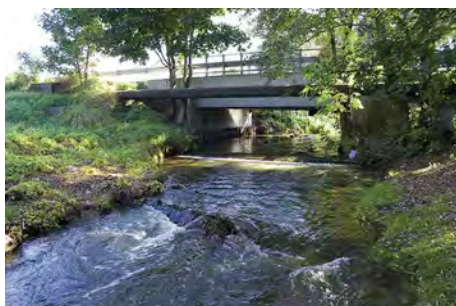
Fot. 124. Rzeka Główna przepływająca pod mostem w ciągu ulicy Gdyńskiej
