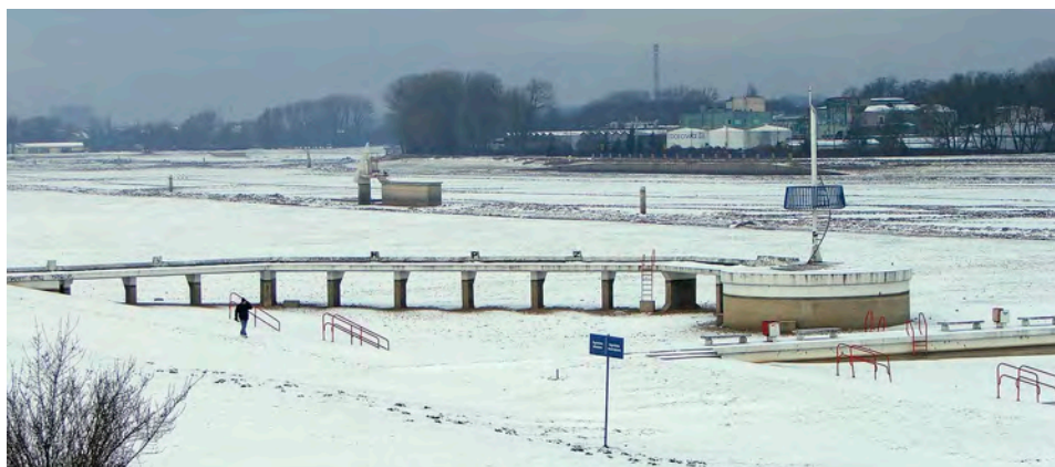
Fot. 12. Zbiornik Maltański zimą 2008 r. podczas przeprowadzania prac konserwacyjnych
