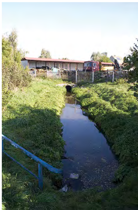
Fot. 149. Potok Wierzbak wypływający z podziemnego kanału w okolicy ulicy Rabczańskiej
