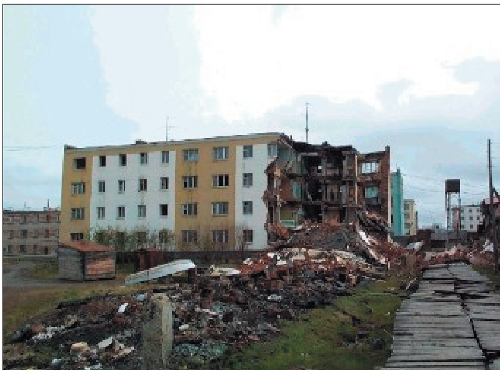
Rysunek 2. Uszkodzenia budynków syberyjskich na skutek topnienia wiecznej zmarzliny (Anisimov i Lavrov 2004, foto W. Romanowski)
